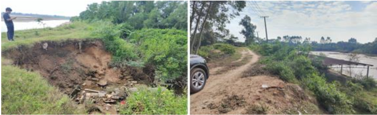
图 3.7-28 乾塘海堤现状照
