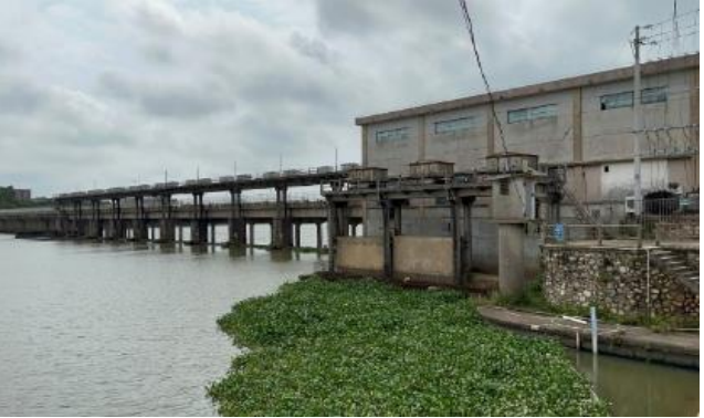
图 3.7-1 吴川市积美拦河闸坝
