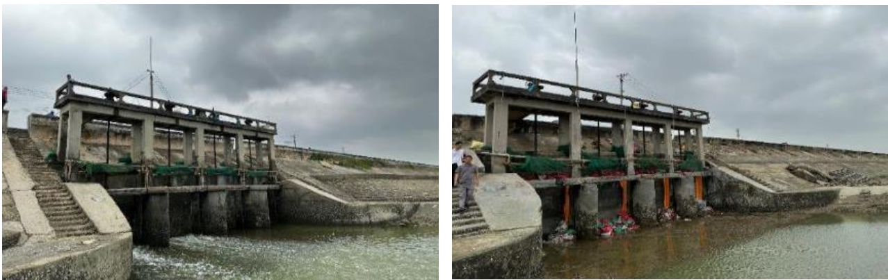
图 3.7-25 白沙水闸、龙湾水闸现场照
