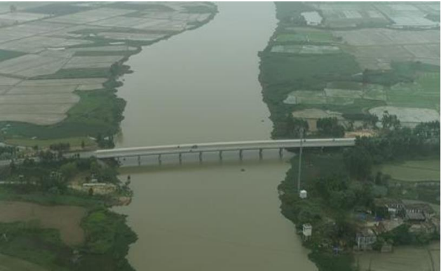
图 3.7-18 南渡河（安榄渡大桥）
