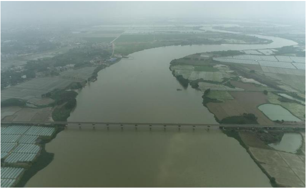
图 3.7-19 南渡河（湛海线铁路桥）
