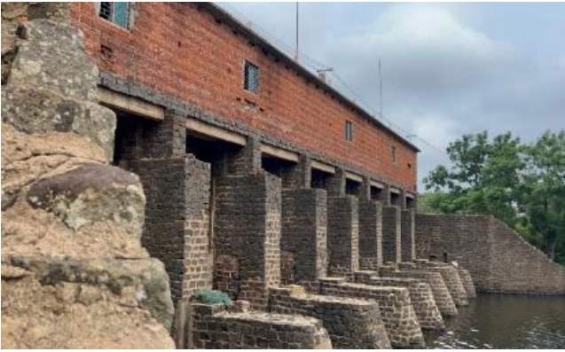
图 3.7-4 徐闻县迈陈后海泄洪闸
