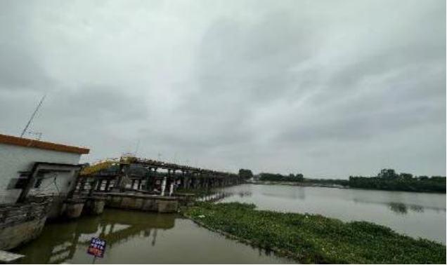
图 3.7-2 廉江市木岭水闸
