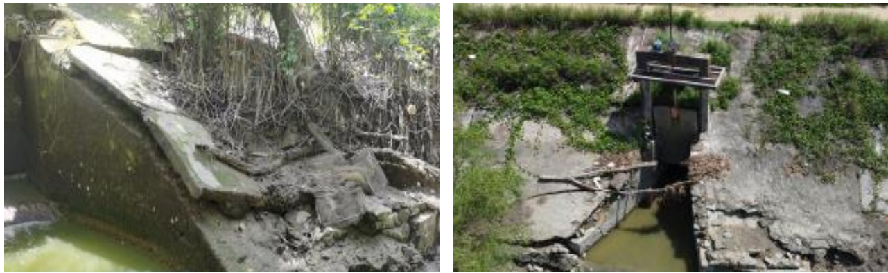
图 3.7-21 现场江洲围部分涵闸情况
