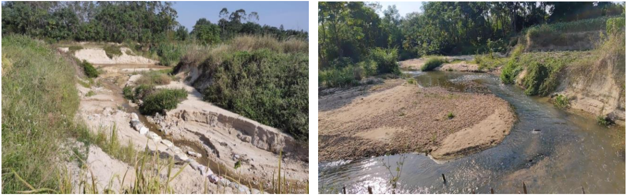
图 3.7-16 沙铲河下游部分河道现状照片（河口冲刷）
