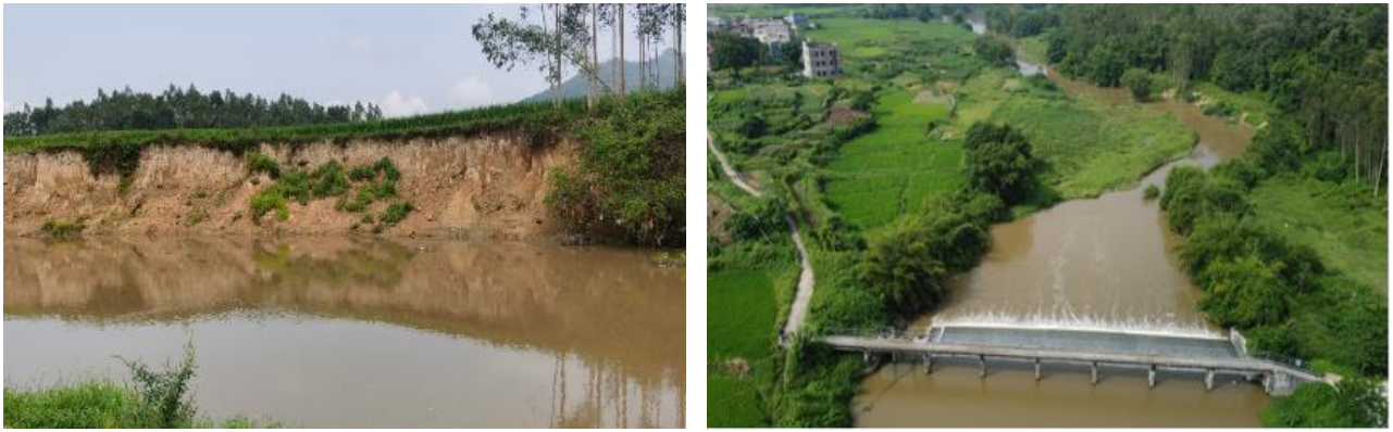
图 3.7-17 塘蓬河部分河段现状照片（岸坡崩塌、河道淤积）
