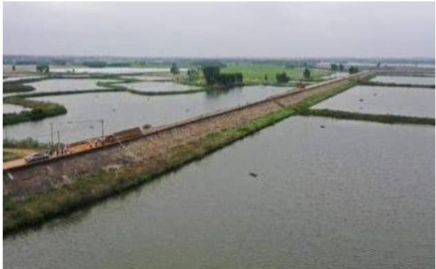
图 3.4-1 南渡河海堤（韶山水闸附近地段迎海侧）
