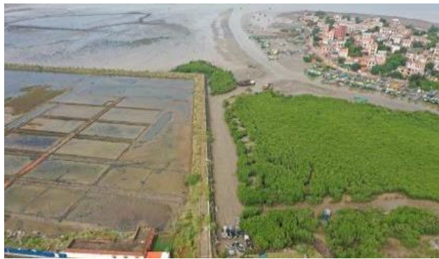
图 3.4-7 南山海堤（航拍）
