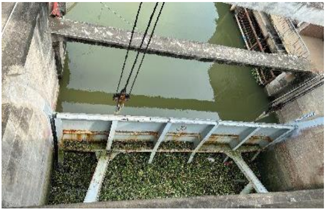
图 3.1-2 塘尾分洪闸闸门
