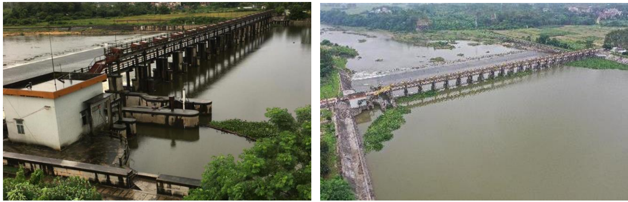
图 3.7-15 木岭水闸现场图
