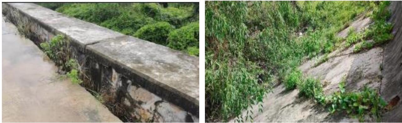
图 3.7-22 现场江洲围部分堤段情况
