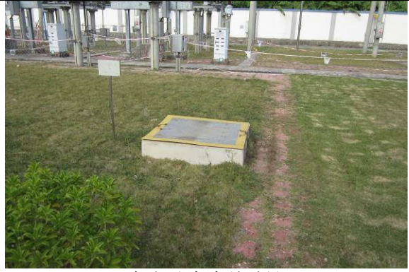
变电站内事故油池
