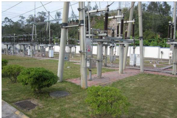
变电站内绿化
