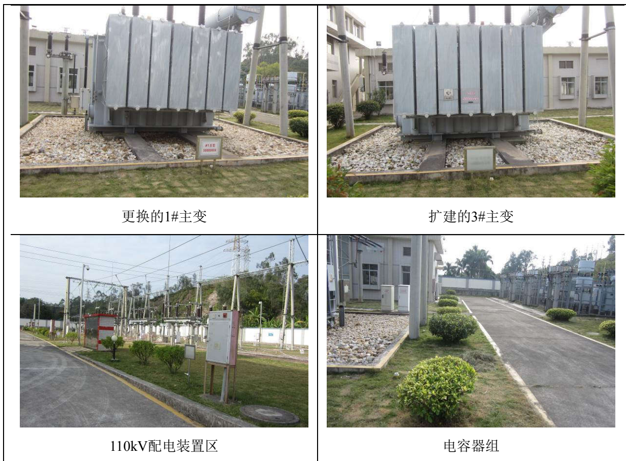
图4-2 110kV鱼窝变电站站内情况
