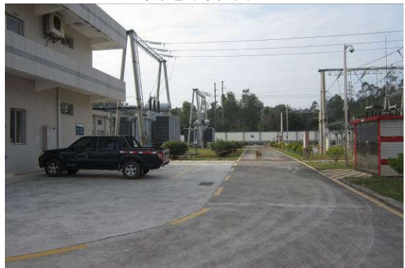
变电站场地平整
