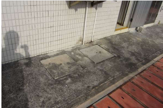
变电站内化粪池
