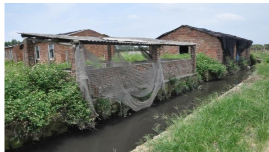
南溪河废弃养猪场
