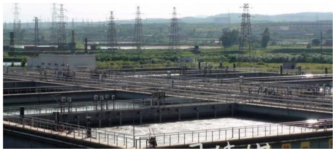
霞山水质净化厂现状
