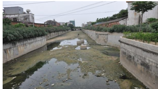
一、二号渠交叉口
