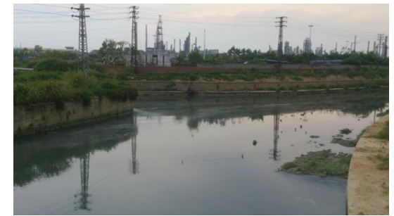
一号渠汇入处
