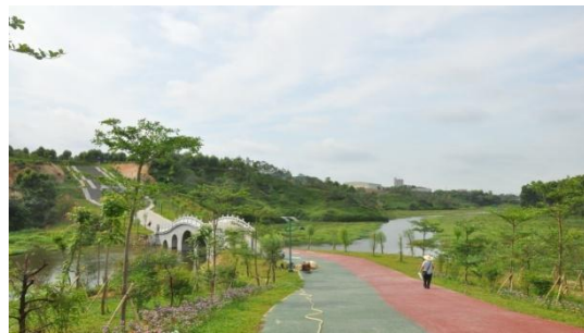
南溪河云溪桥
