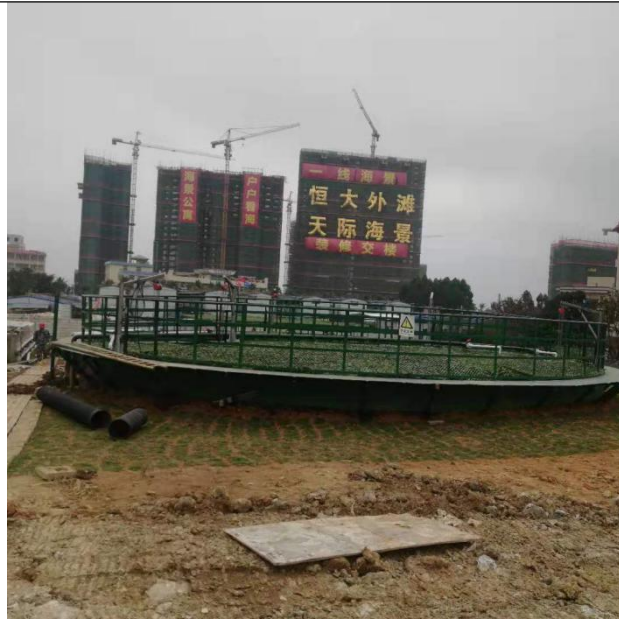
图7-5 污水处理设施
