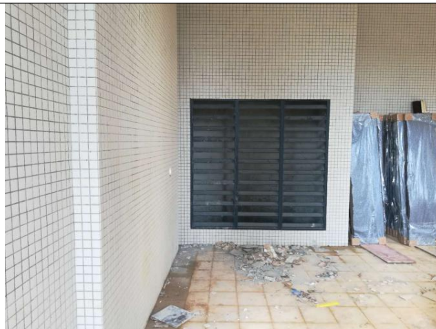
图7-11 地下室换气口
