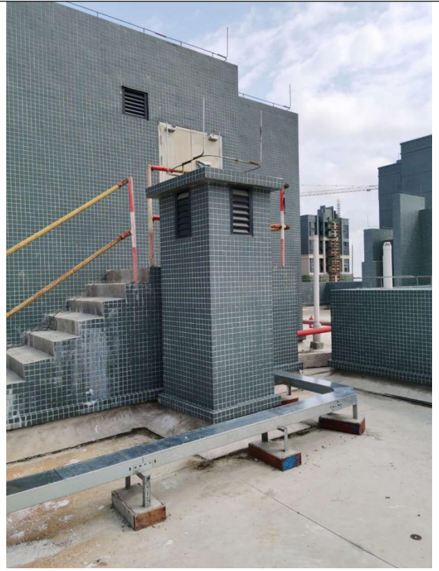
图7-10 居民厨房烟道
