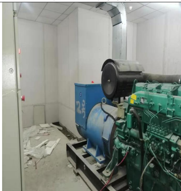
图7-12 备用发电机房（墙体隔声）
