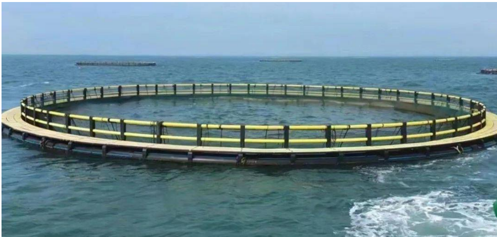
图 1.5-15 浮于水面的重力式深水网箱浮力装置（框架系统）
