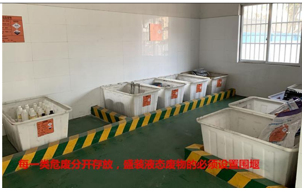
图4-4 危废暂存间围堰布置参考样图
