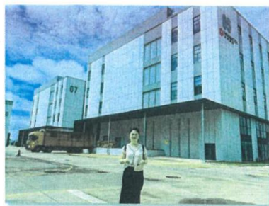
工程师看现场照片2（东面5栋）
