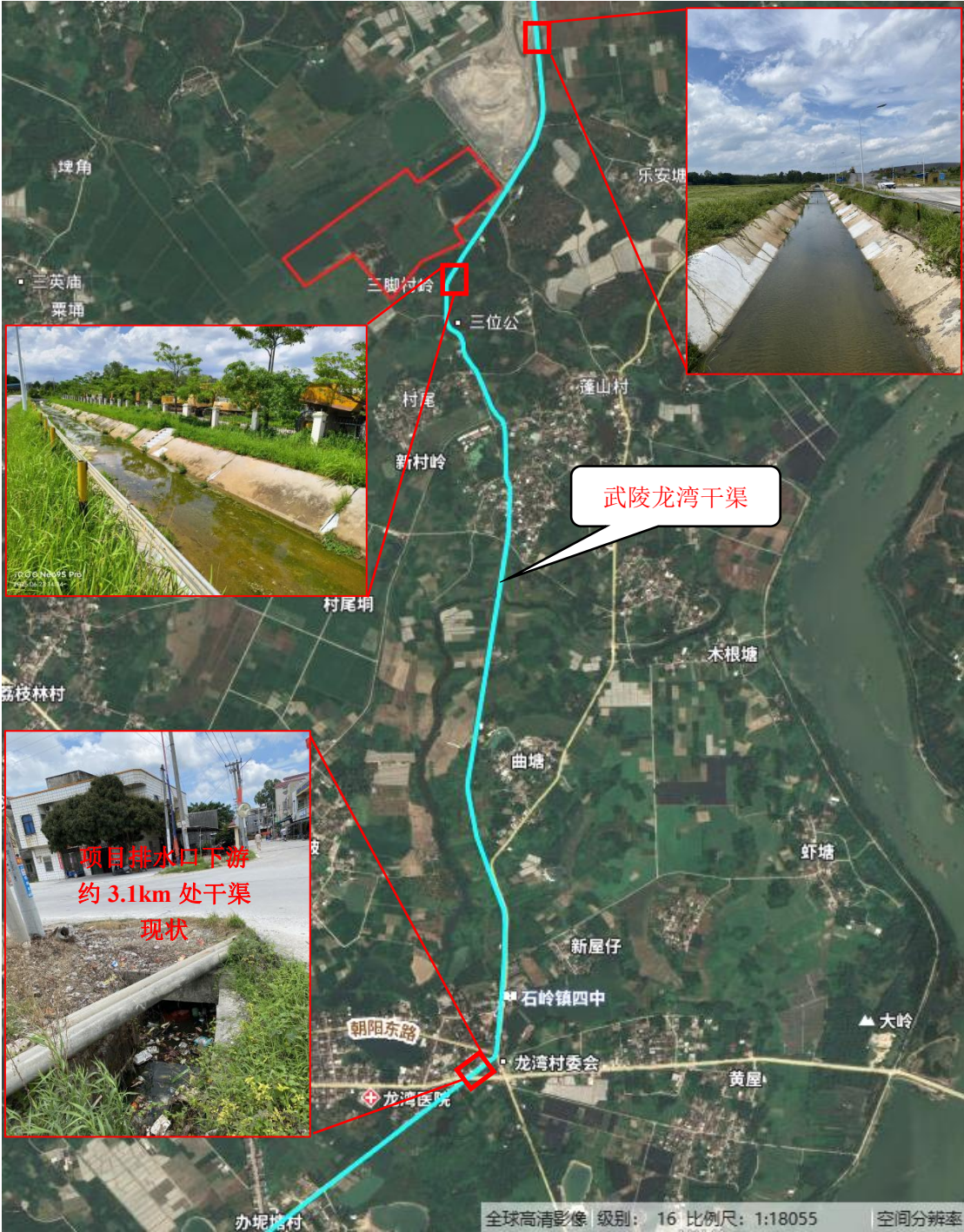
图 6.2-1 项目武陵龙湾干渠现状图
