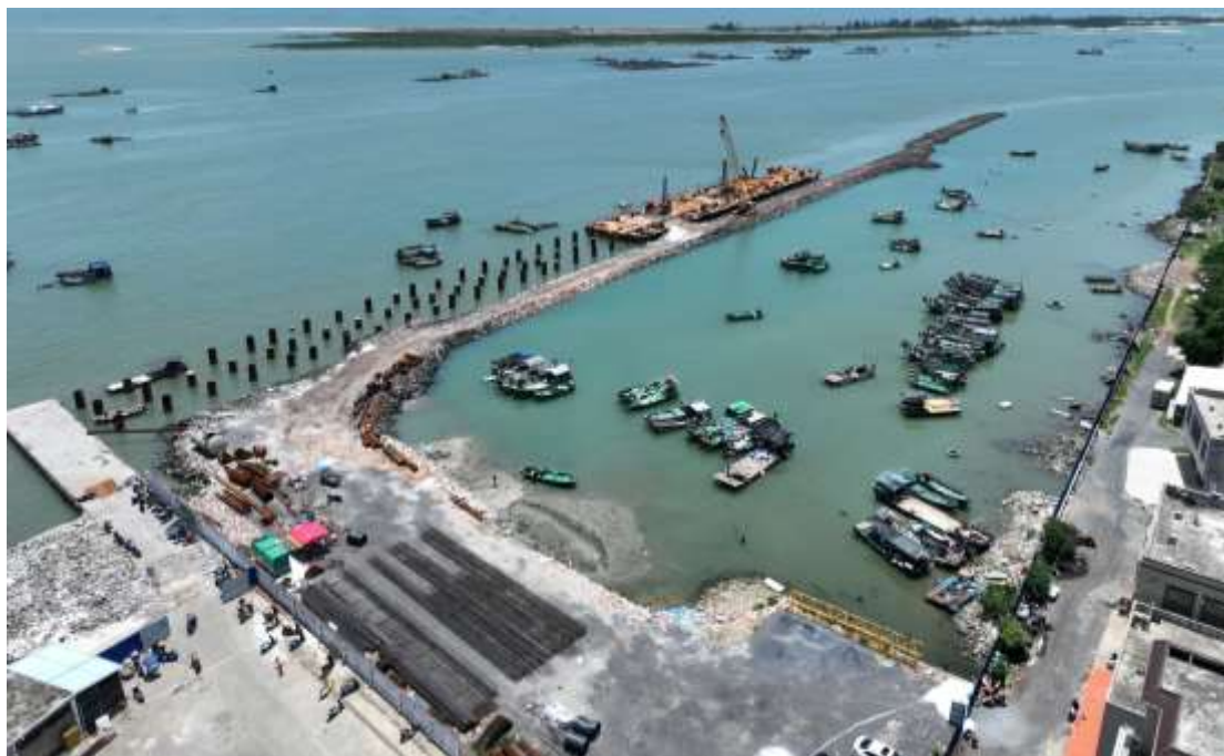
图 3.1-5 湛江东海岛东南渔港一期工程施工进度现状图(2026 年 5 月)
