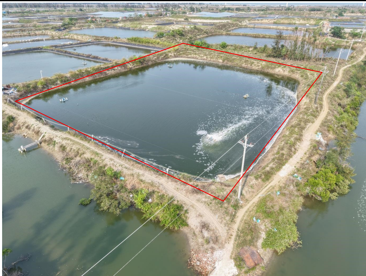
图3-2 站址现状情况照片
