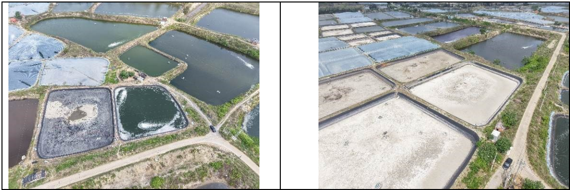
图 2-4 白岭风电场道路现状
