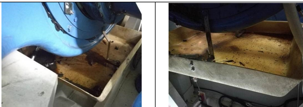
图 4-7 其他风电场风机发电机集油槽图
