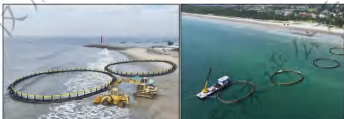
图 2-11 深水网箱下海、运输示意图
