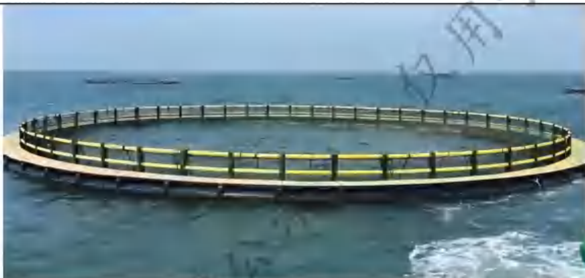
图 2-6 浮于水面的重力式网箱框架系统
