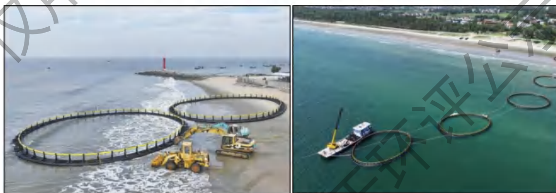
图 2-11 深水网箱下海、运输示意图
