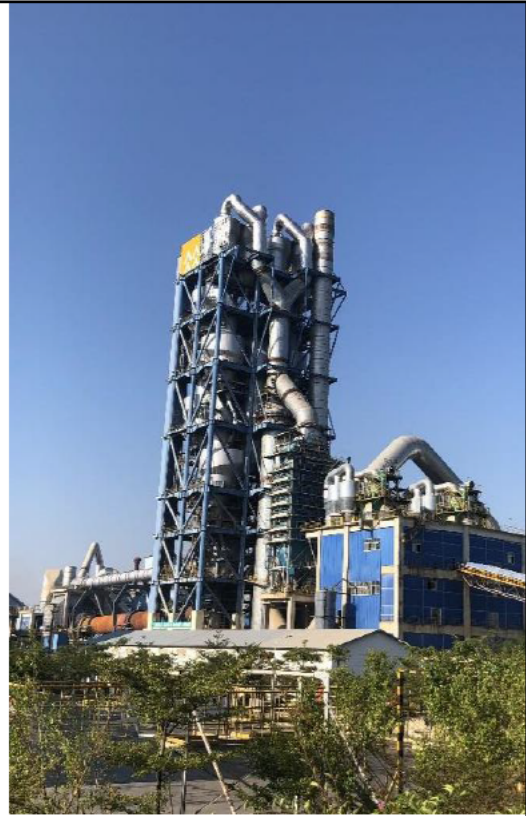
现有窑尾除尘器
