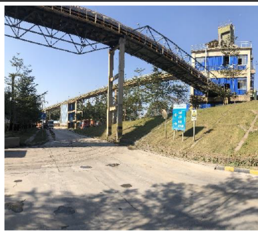
现有石灰石密闭输送廊道
