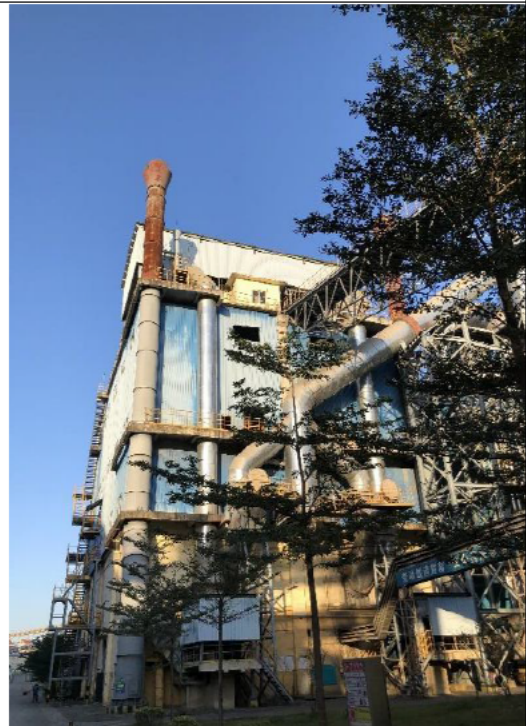
现有煤磨系统除尘器
