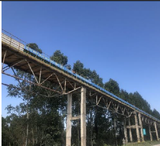
现有石灰石密闭输送廊道
