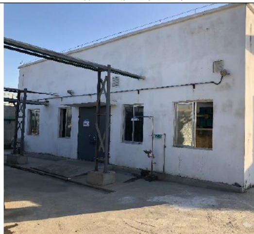
现有工业废水处理站（回用车间）
