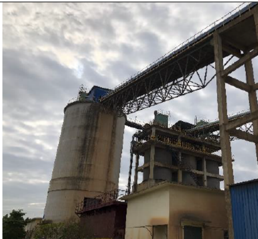
现有物料转运密闭输送廊道
