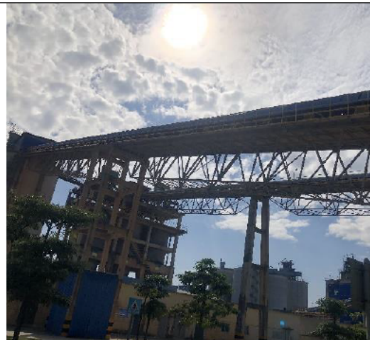
现有物料转运密闭输送廊道
