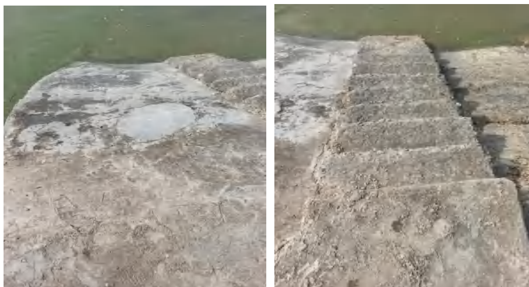
图 2.5.1-1 上下游翼墙外观质量缺陷图
