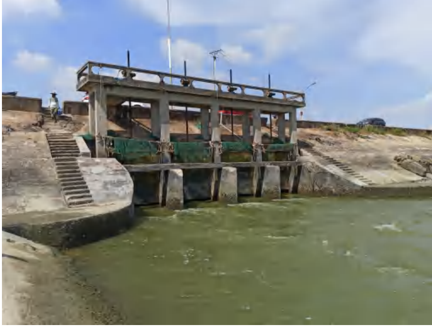
图 2.5.1-3 水闸外海侧图
