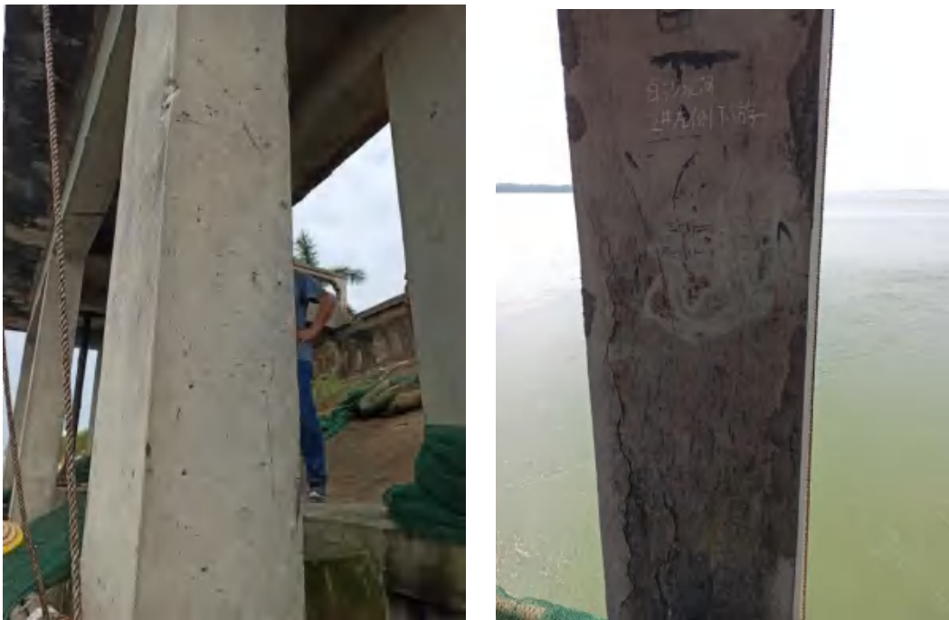
图 2.5.1-5 水闸闸墩外观质量缺陷图
