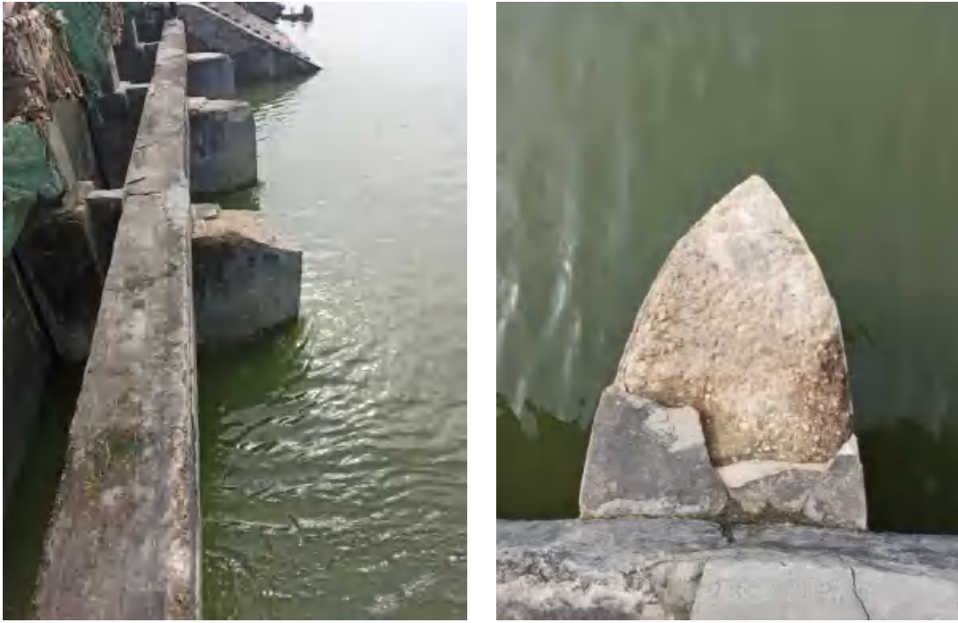
图 2.5.1-5 水闸闸墩外观质量缺陷图
