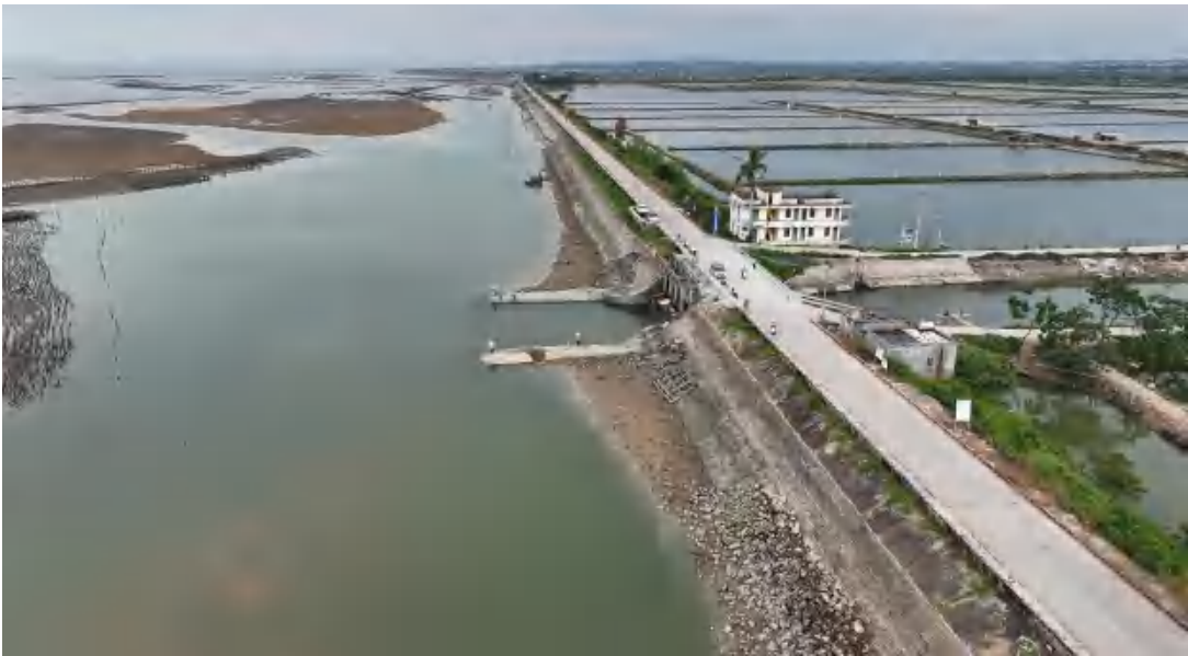
图 2.5.1-10 白沙水闸现场照片图（拍摄时间：2025 年 6 月 29 日）
