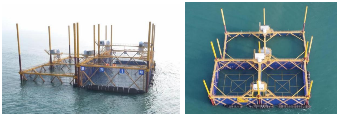
图 3.3.2-5 湛农 1 号桁架类网箱结构图
