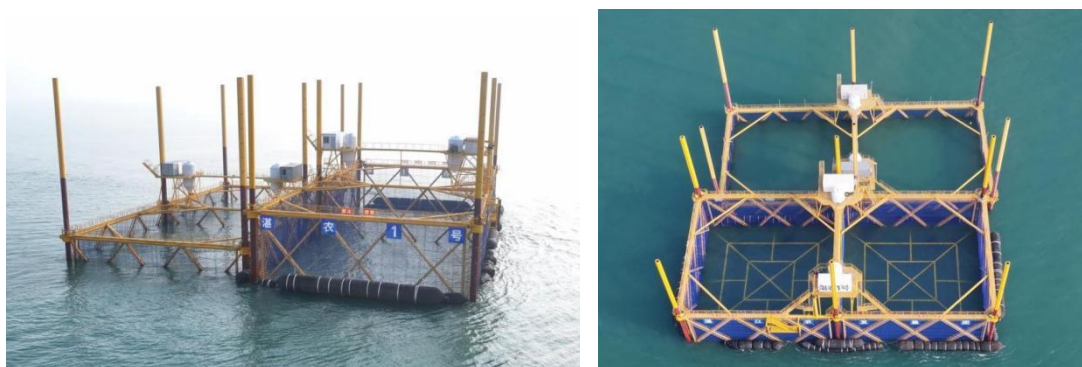
图 3.3.2-5 湛农 1 号桁架类网箱结构图
