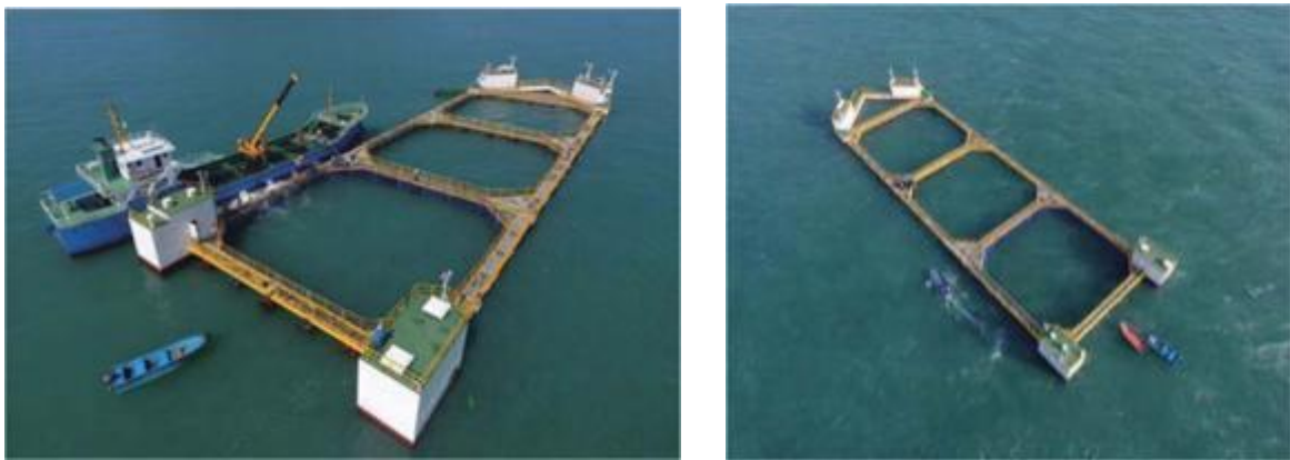
图 3.4.7 桁架类网箱 (德海 1 号) 实景图
