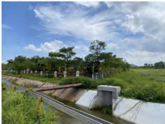
矿区东侧武陵龙湾干渠现状
