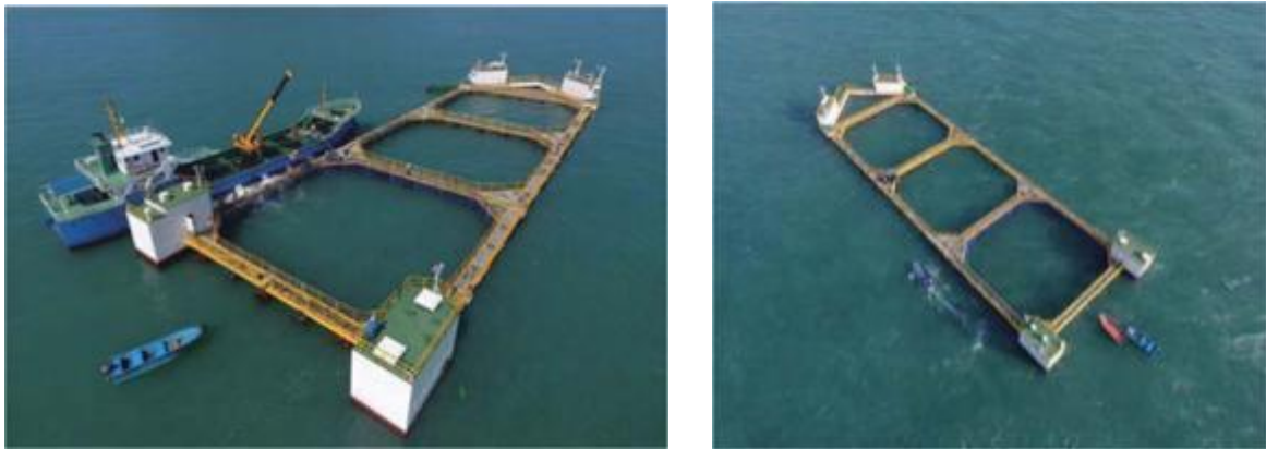
图 3.4-7 桁架类网箱（德海 1 号）实景图
