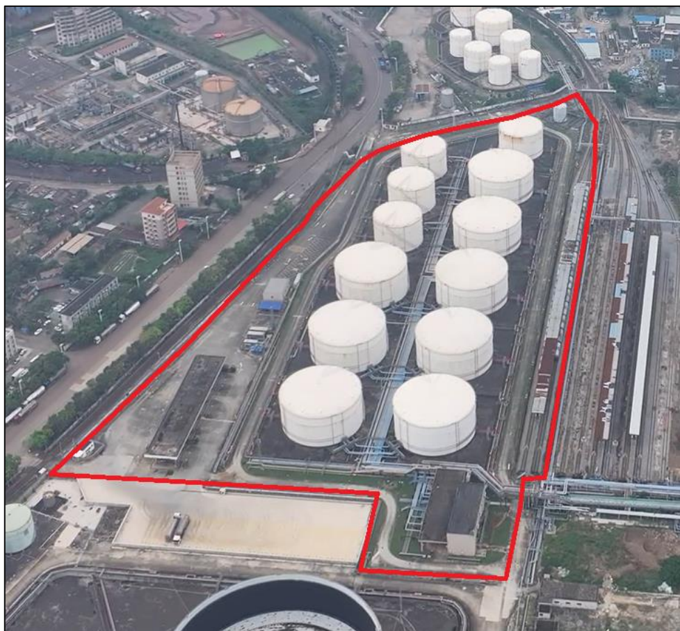
图 2.3-5 3#罐区实际建设情况图
