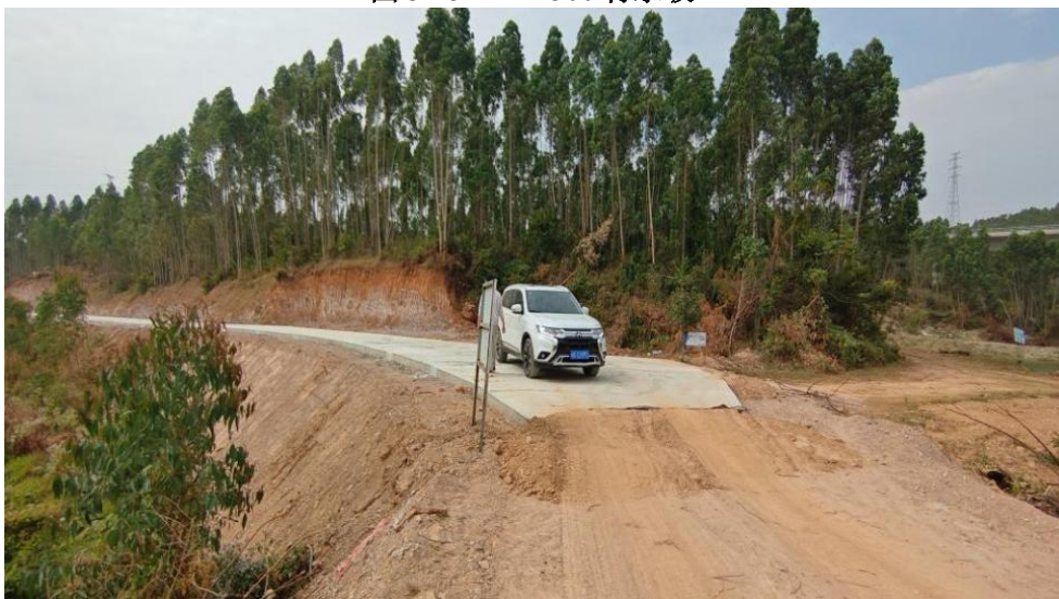
图 3-24 K4+350 堤顶路面
