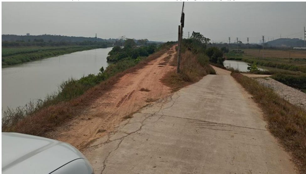
图 3-18 K2+732 堤顶路面
