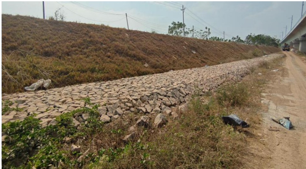
图 3-11 K1+516~K1+707 背水坡植草护坡、抛石护脚
