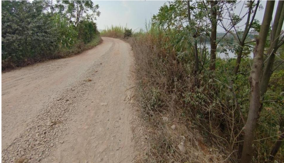
图 3-8 K0+450 堤顶路面
