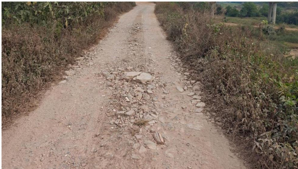
图 3-5 K0+065 碎石路面凹凸不平
