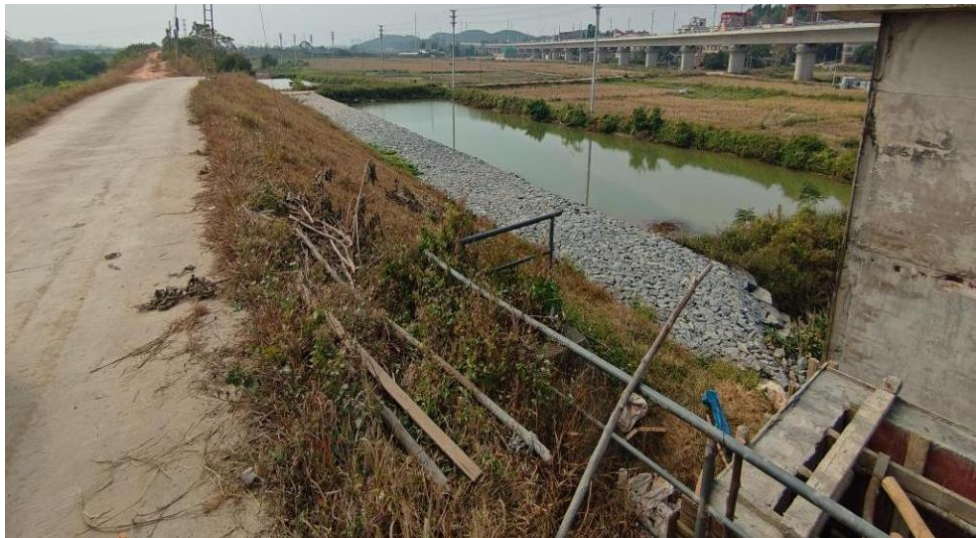
图 3-17 K2+631~K2+715 背水坡抛石护脚
