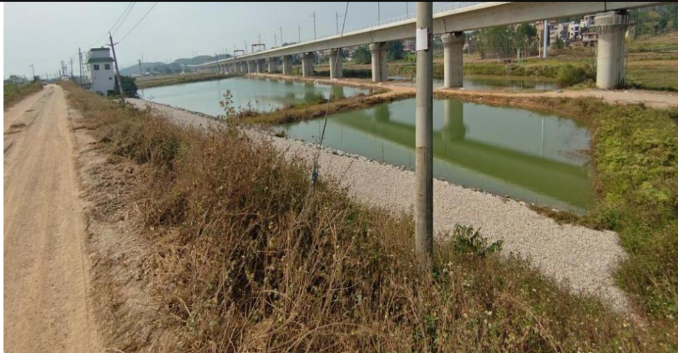
图 3-16 K2+370~K2+519 段背水坡抛石护脚
