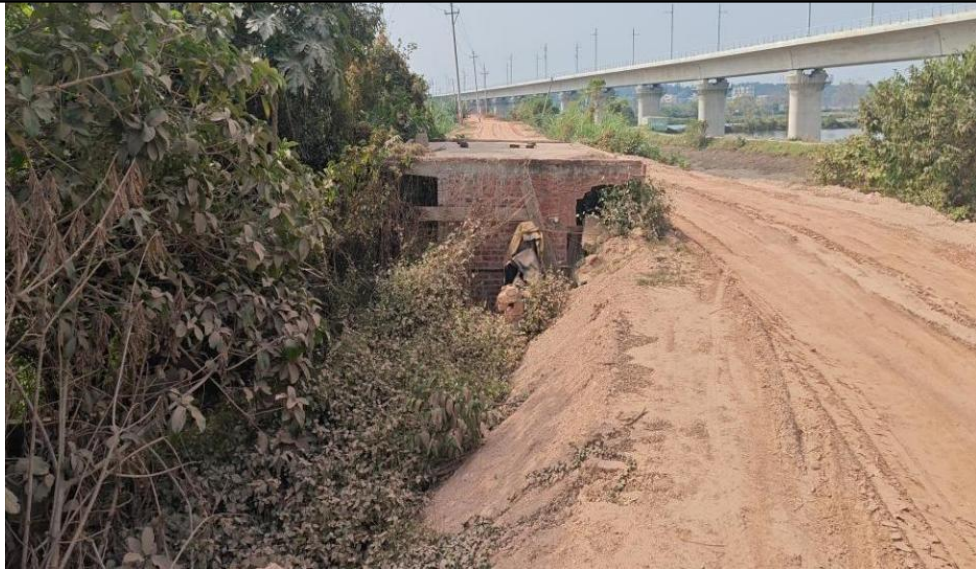
图 3-10 K1+180 堤坝矮小、吴川高铁（在建）
