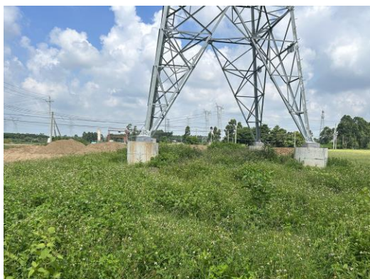
照片 5 塔基区植被恢复 1
