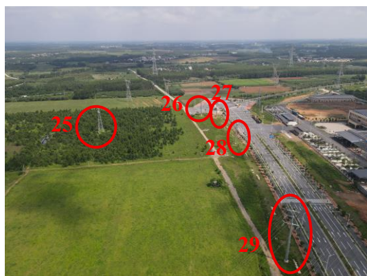
照片 9 塔基 N25~N29 现状
