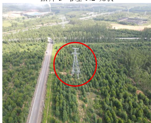
照片 5 塔基 N4 现状
