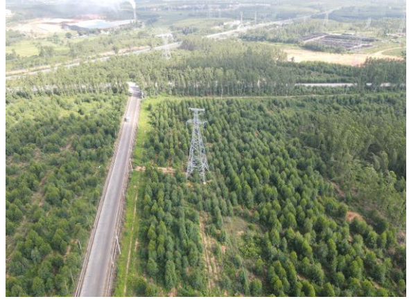
照片 2 塔基周边现状 2
