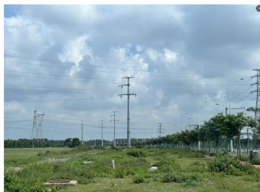
照片 6 塔基区植被恢复 2
