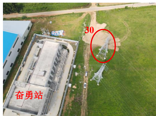
照片 10 塔基 N30 现状
