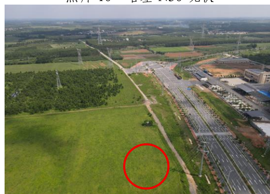
照片 12 牵张场区现状
