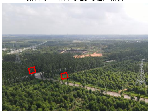
照片 11 跨越施工场地区现状
