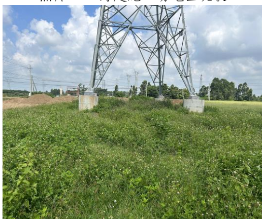
照片 13 塔基区植被恢复
