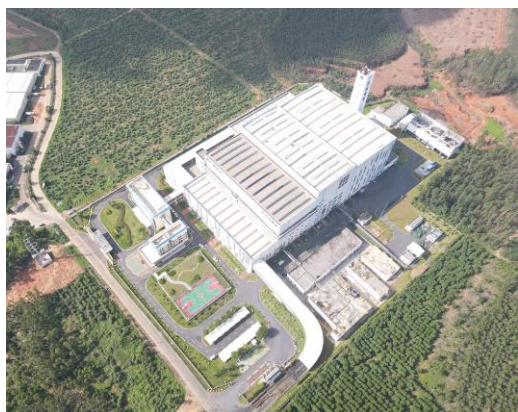
照片 1 雷州垃圾发电站现状
