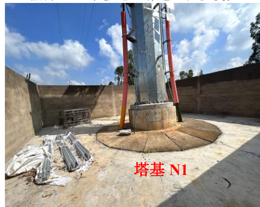
照片 16 电缆终端围墙内部现状
