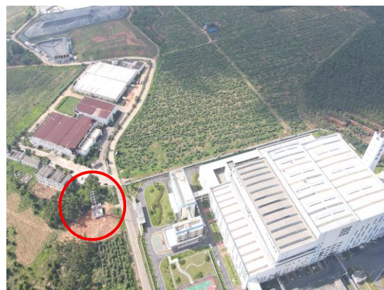
照片 2 塔基 N1 现状
