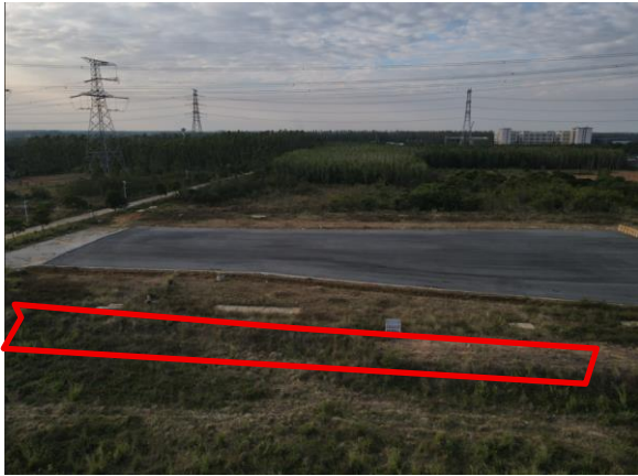
吉隆坡南路临时堆土场撒播草籽
