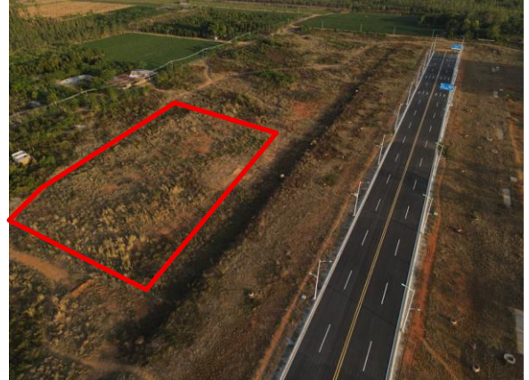
万象中路施工临建区撒播草籽
