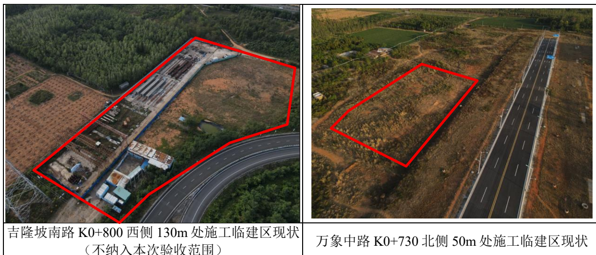
图 1.1-6 施工临建区现状
