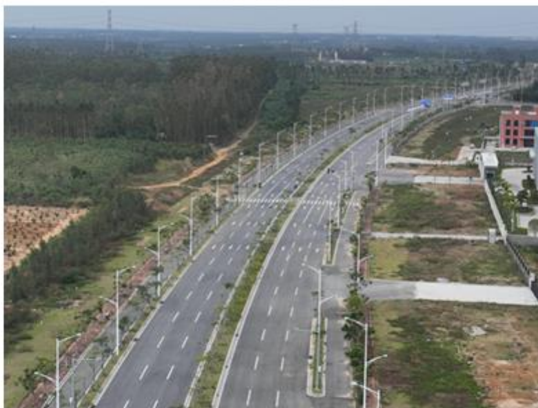
图 1 道路一期已完工
