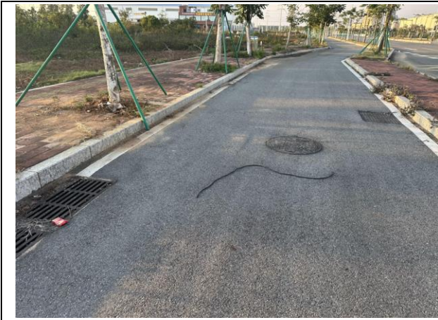
仰光路雨水管道
