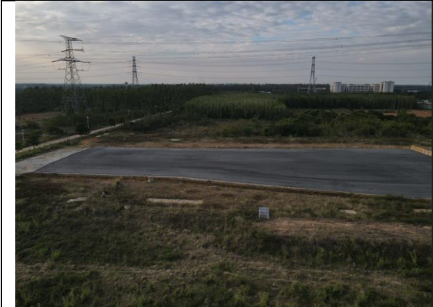
吉隆坡南路喷播植草护坡
