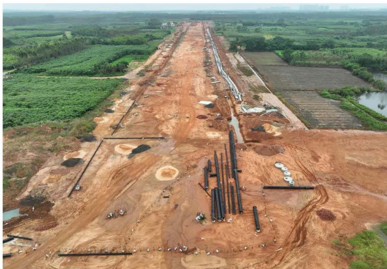
图 1 万象中路施工现状
