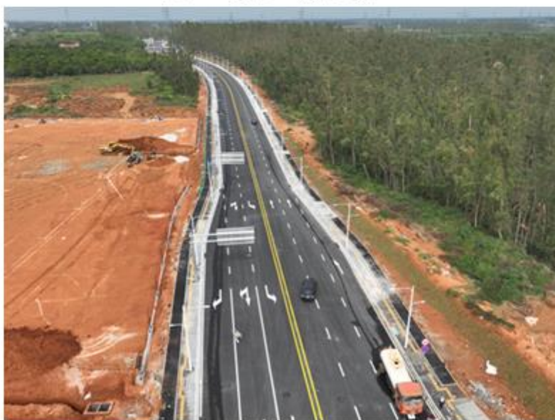
图 2 道路二期施工现状
