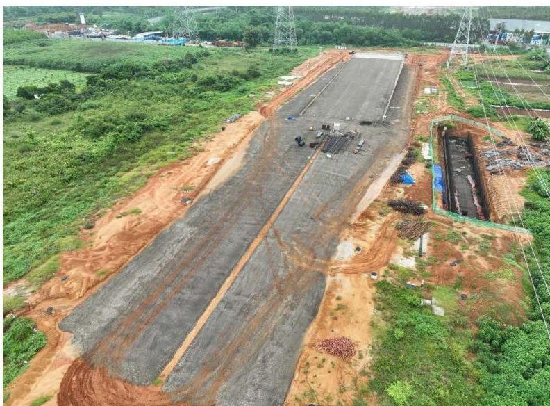
图 2 吉隆坡南路施工现状
