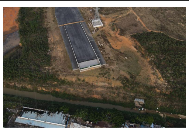
吉隆坡南路喷播植草护坡
