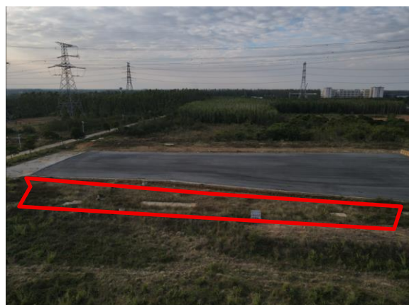
吉隆坡南路 K0+600 南侧临时堆土场现状
