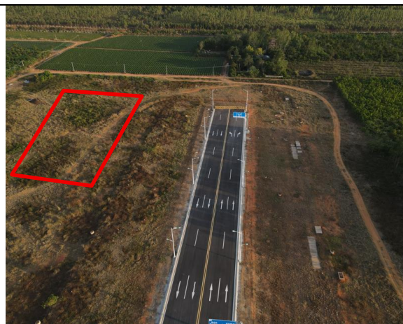
万象中路终点北侧临时堆土场现状
