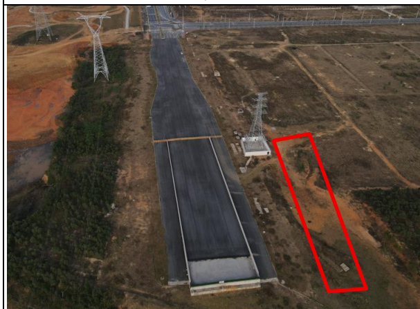
吉隆坡南路 K1+100 南侧临时堆土场现状
