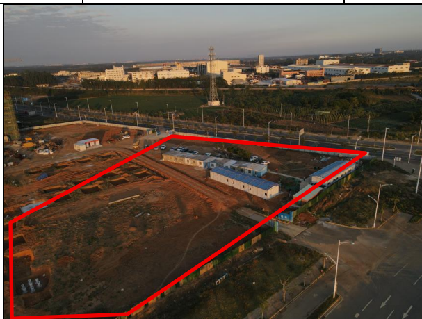
仰光路终点北侧临时堆土场现状（其它项目建设中）
