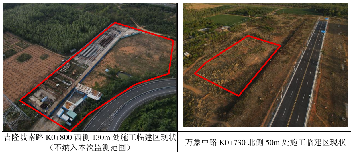
图 3-1 施工临建区现状
