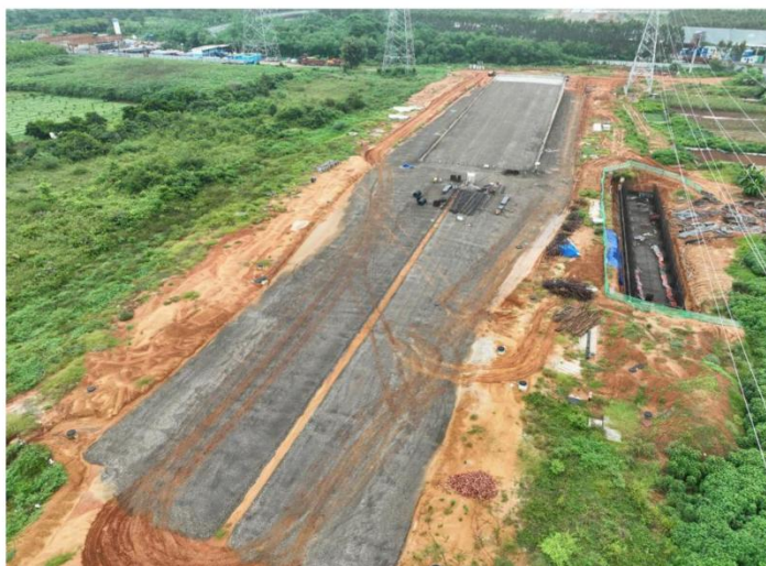
图 2 吉隆坡南路施工现状
