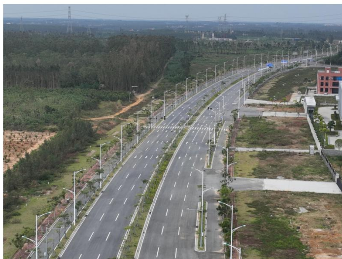
图 1 道路一期已完工
