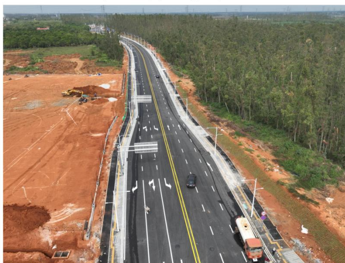
图 2 道路二期施工现状
