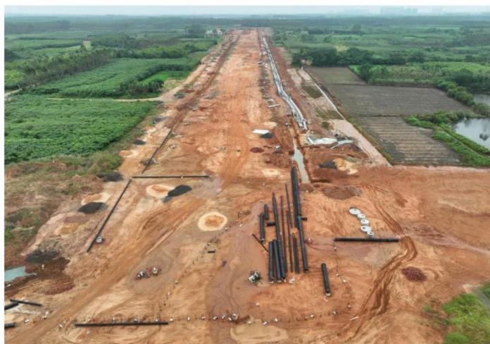
图 1 万象中路施工现状
