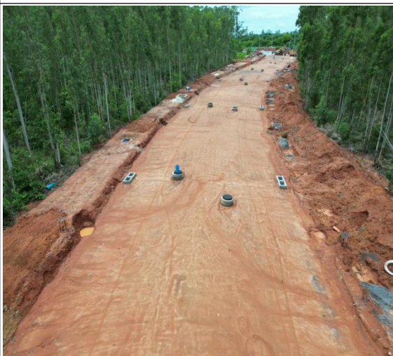
道路施工建设情况
