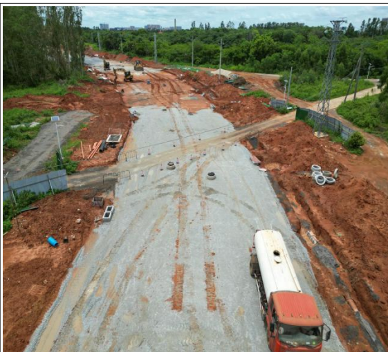
道路施工建设情况
