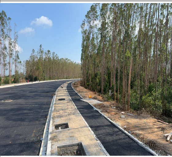
道路施工建设情况
