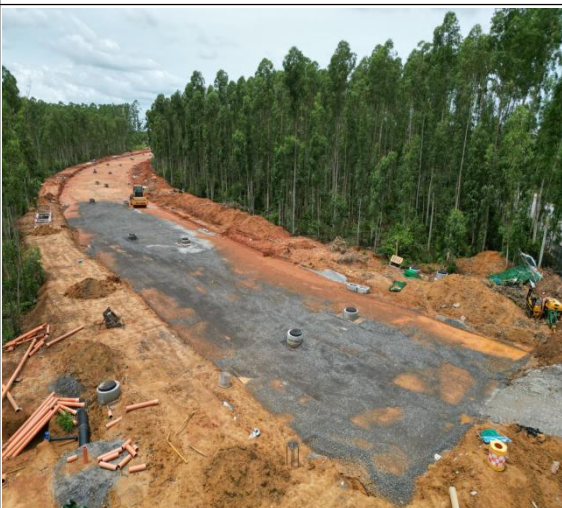
道路施工建设情况
