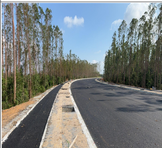
道路施工建设情况
