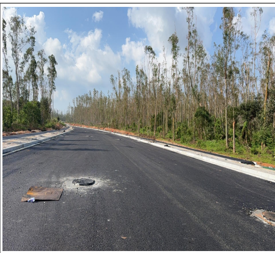
道路施工建设情况
