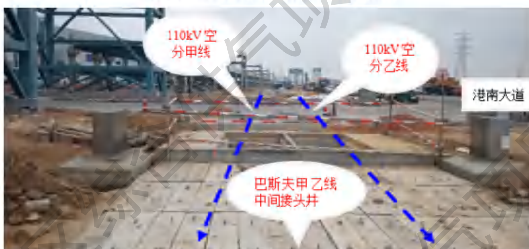
图 2-6 220kV 电缆巴斯夫甲乙线中间接头井敷设情况
