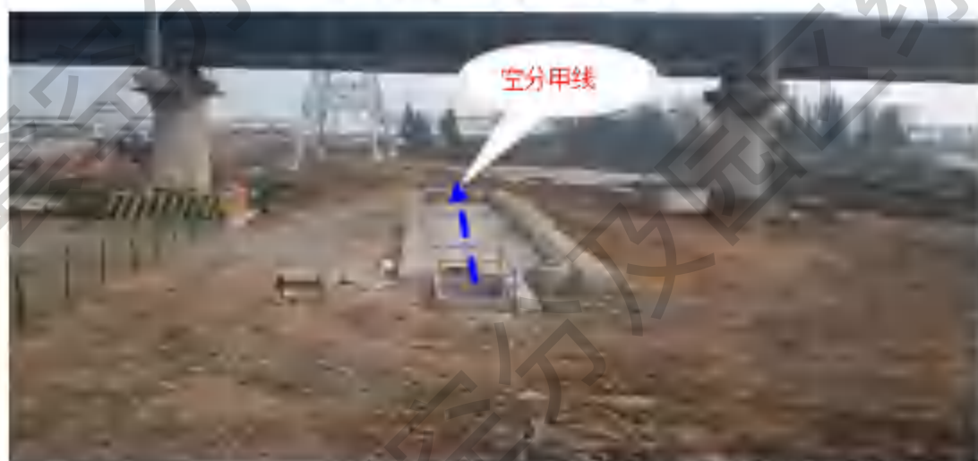
图 2-2 110kV 电缆穿越东海岛铁路桥敷设情况
