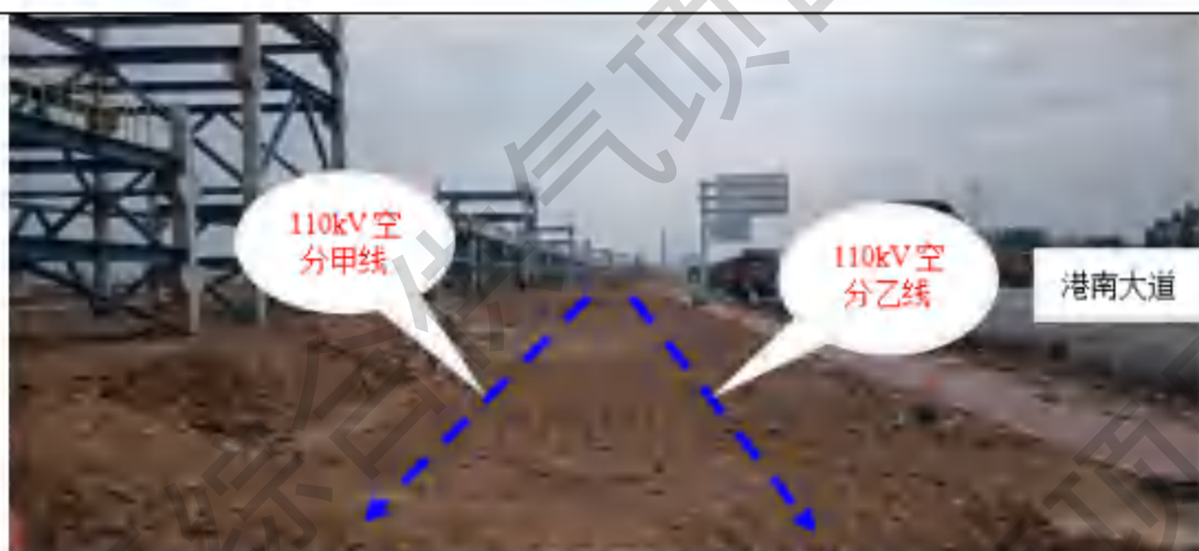
图 2-9 110kV 电缆沿港南大道敷设情况
