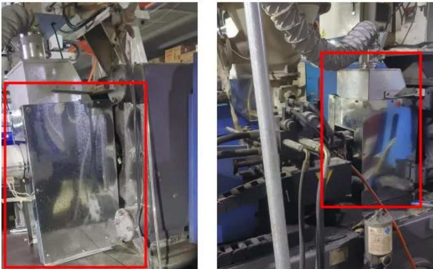
图 4-1 参考案例项目挤出废气集气罩设置现场照片
