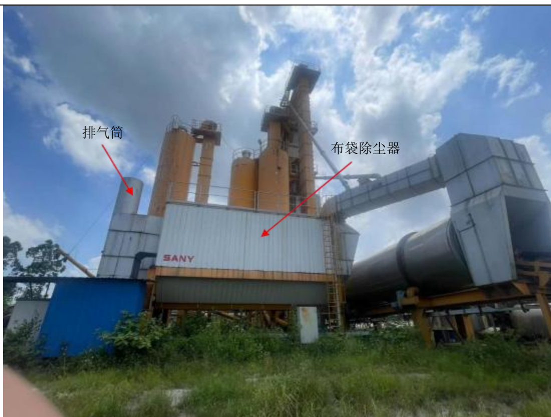
图 2-3 物料烘干、筛分废气滤芯式布袋除尘器+排气筒（DA002）
