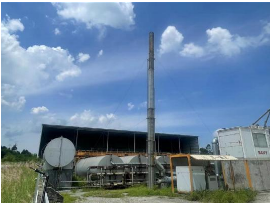
图 2-5 沥青拌合、装卸料和沥青储罐呼吸废气治理设施+15 米排气筒（DA004）
