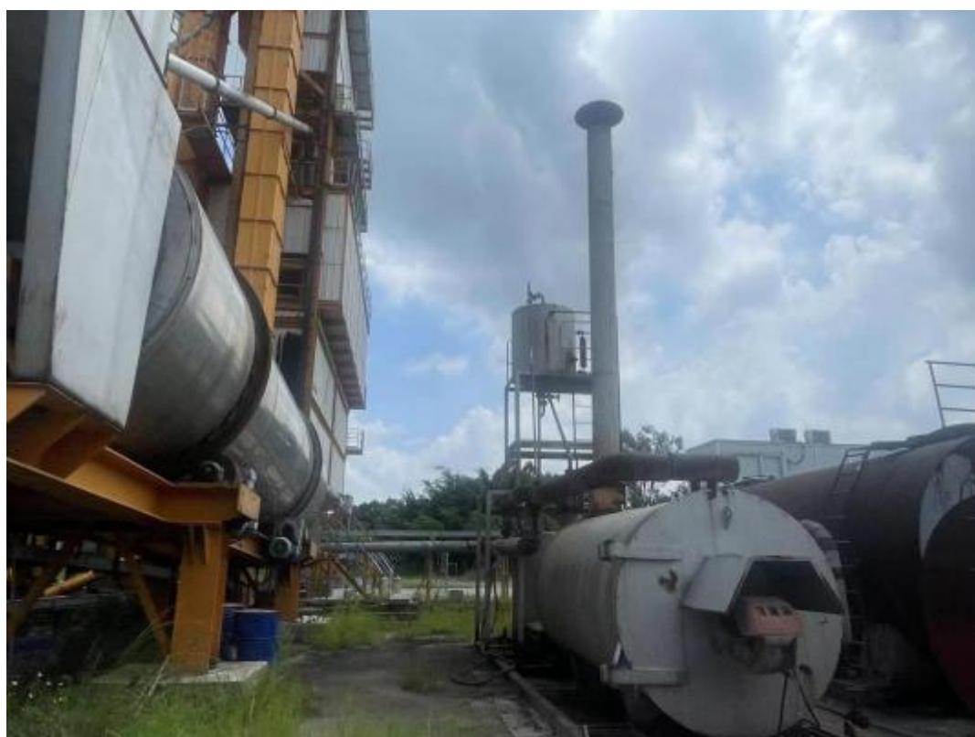
图 2-4 导热油炉废气 15 米排气筒（DA003）
