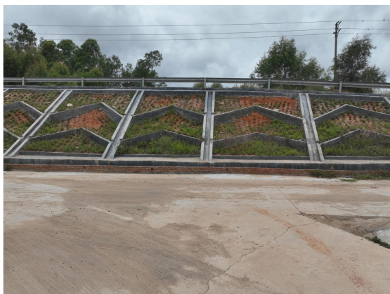
进站道路区混凝土护坡
