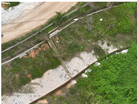
进站道路区砖砌排水沟、挡土墙、急流槽、六棱转护坡
