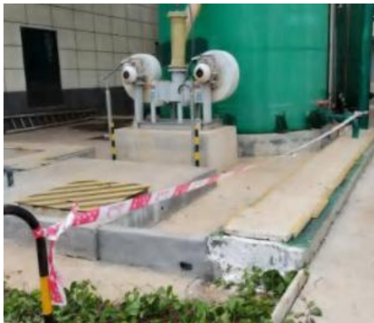
次氯酸钠储罐处围堰
