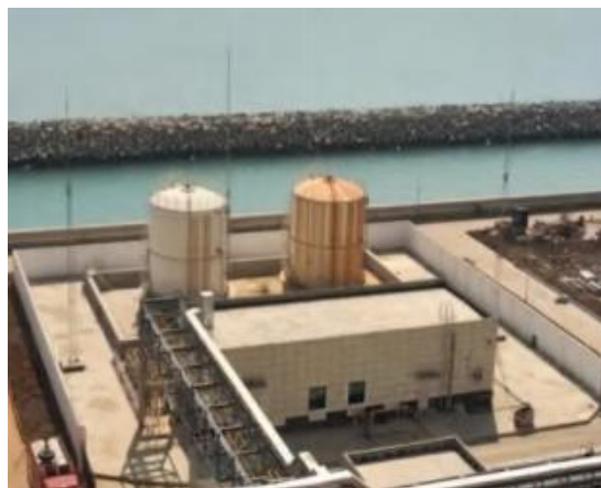
油储罐及储罐区围堰
