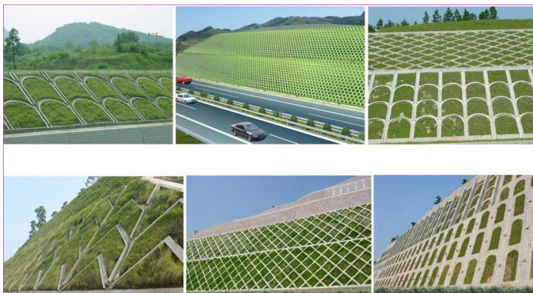
图 3.1-5 各类边坡防护示意图
