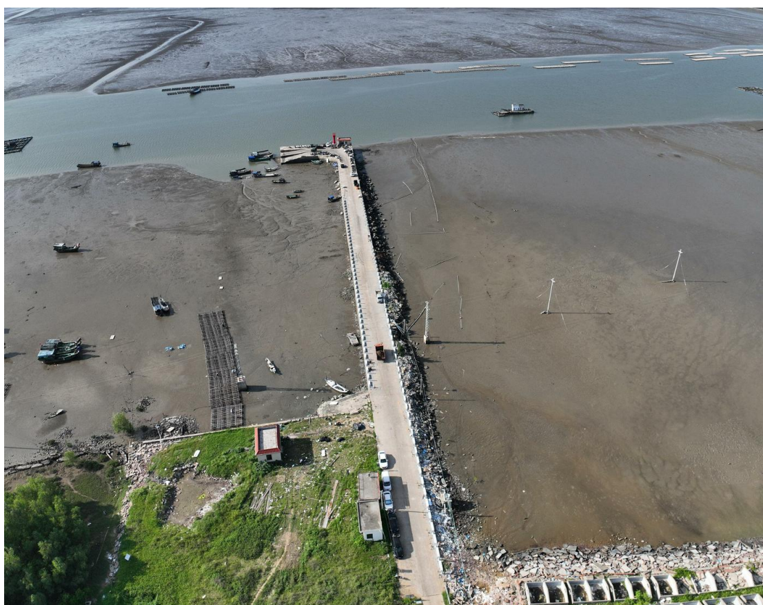
图 2.1-3 项目现状照片 2
