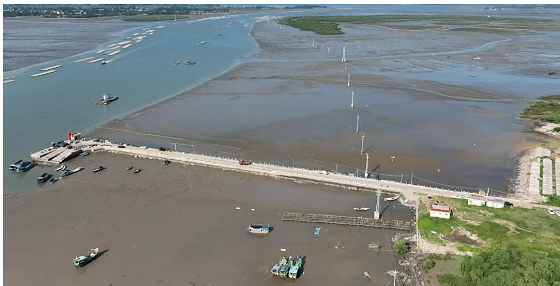
图 2.1-2 项目现状照片 1
