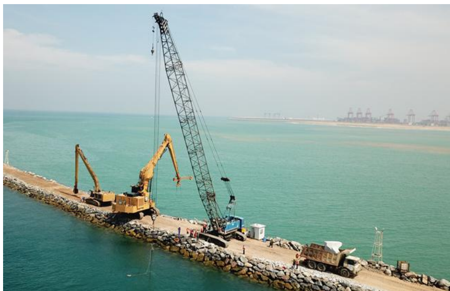
图 2.3.1-1 引堤施工示意图
