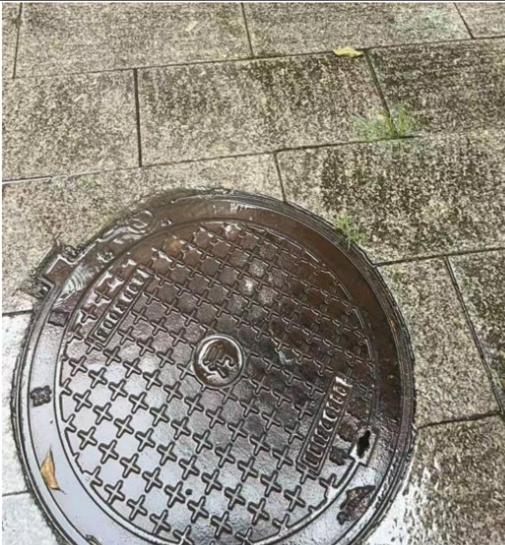
图 4.2.2.5-2 生活污水排放口
