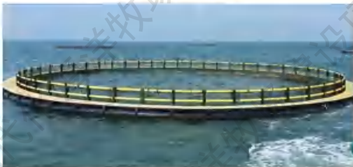
图 3.2-16 浮于水面的重力式网箱框架系统
