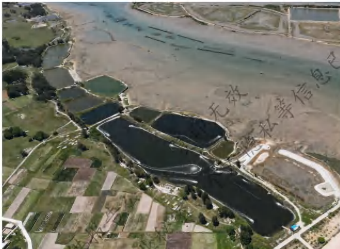
图 5.1.2-4 海堤南侧养殖围塘现状
