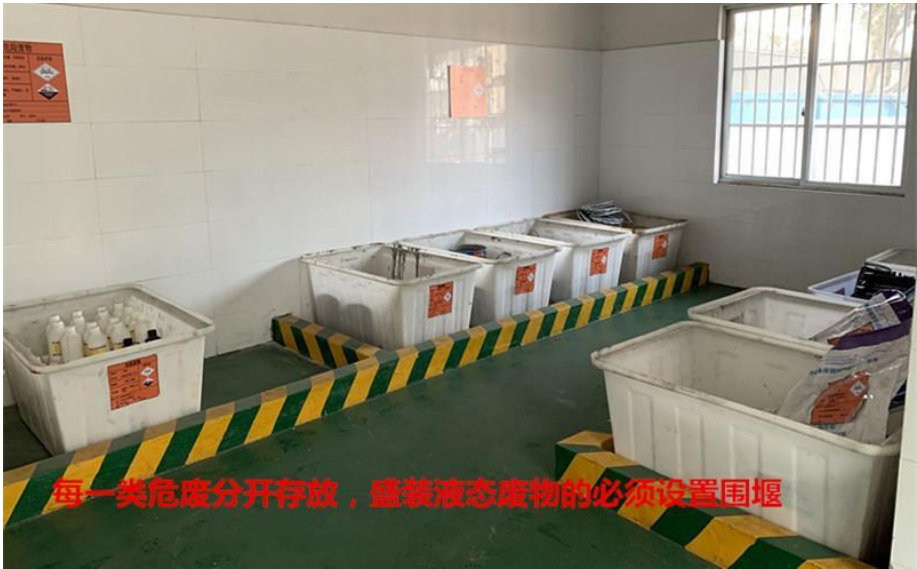
图4-6 危废暂存间围堰布置参考样图
