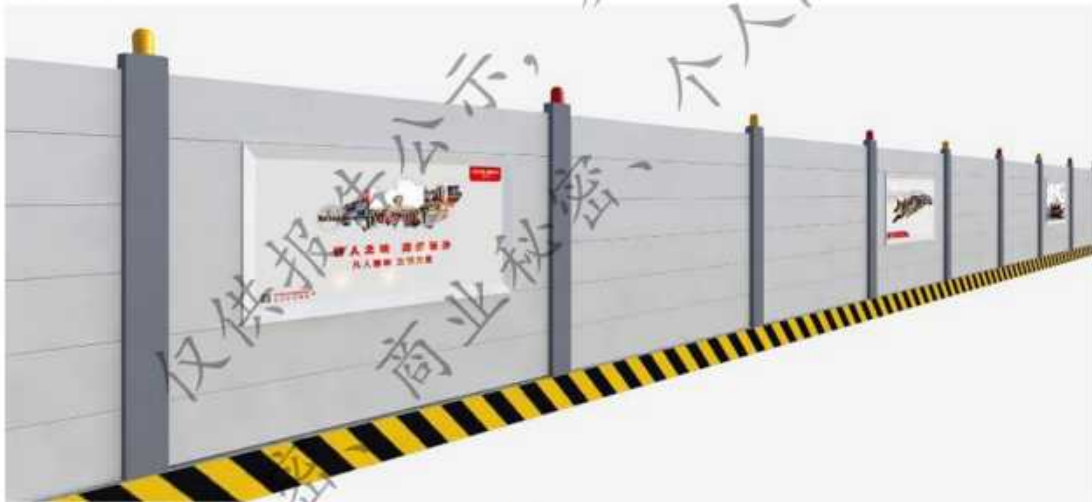
图 2.3.1-1 陆域施工围挡
