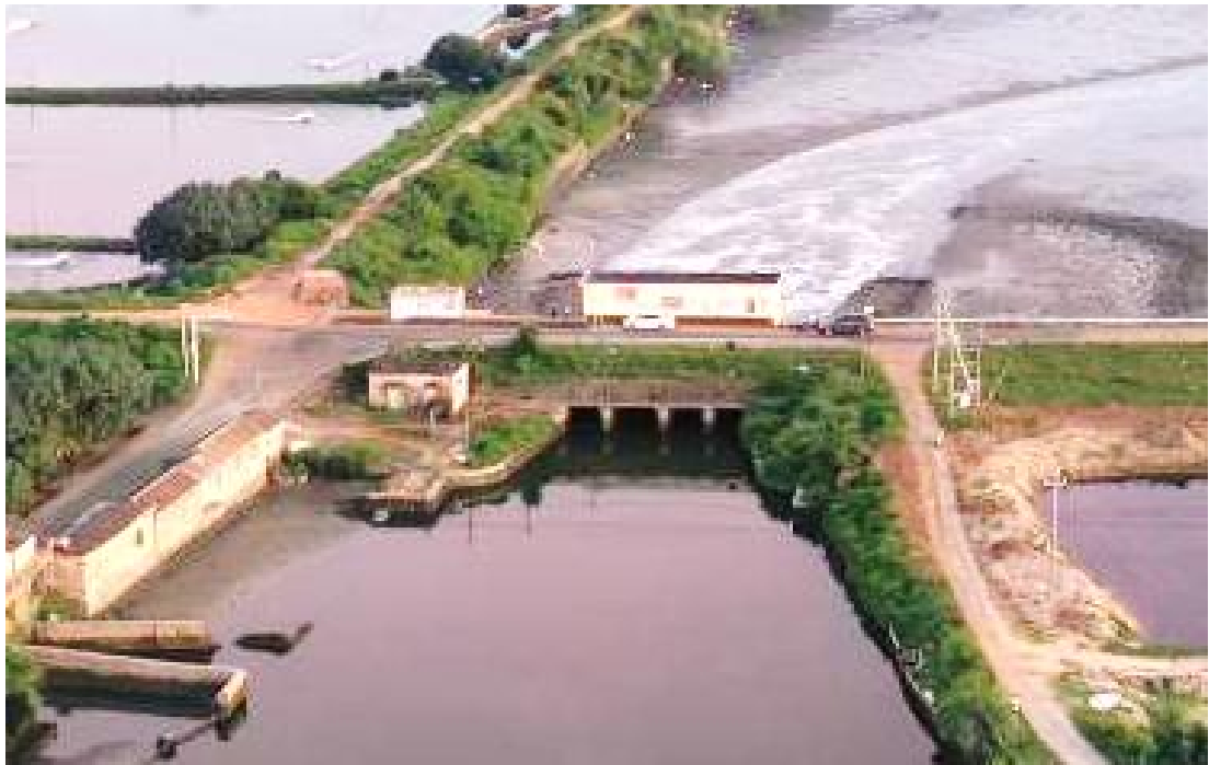
图2.1-2 东里堵海纳潮排洪闸（从上游向下游看）
