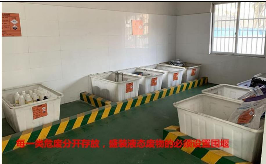
图4-6 危废暂存间围堰布置参考样图
