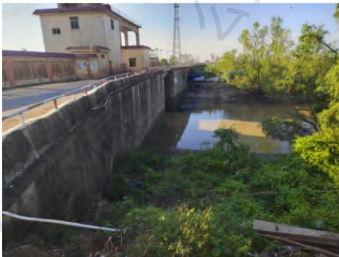
图 2.1.2-2 旧吊桥下游侧现状
