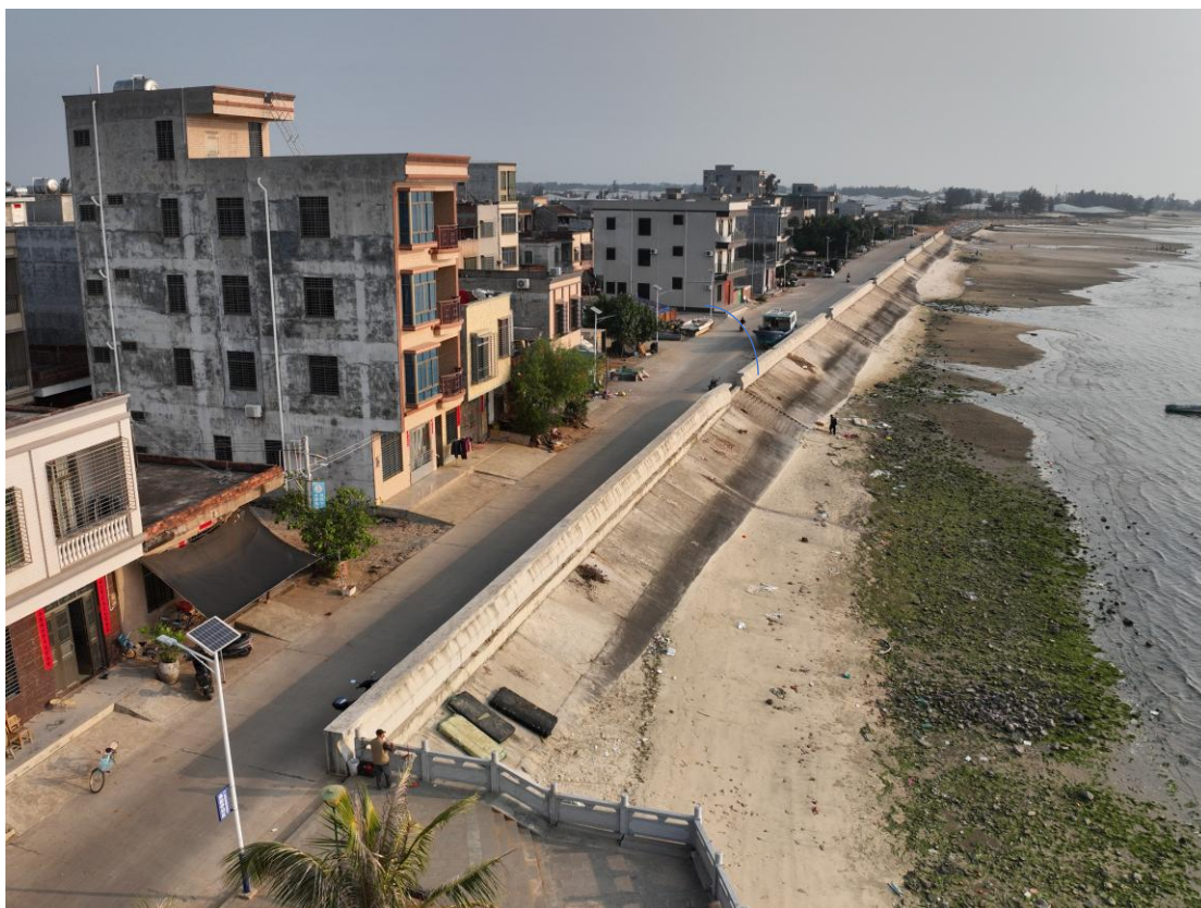
图 2.1.3-2 项目护岸现状（拍摄于 2025 年 3 月）
