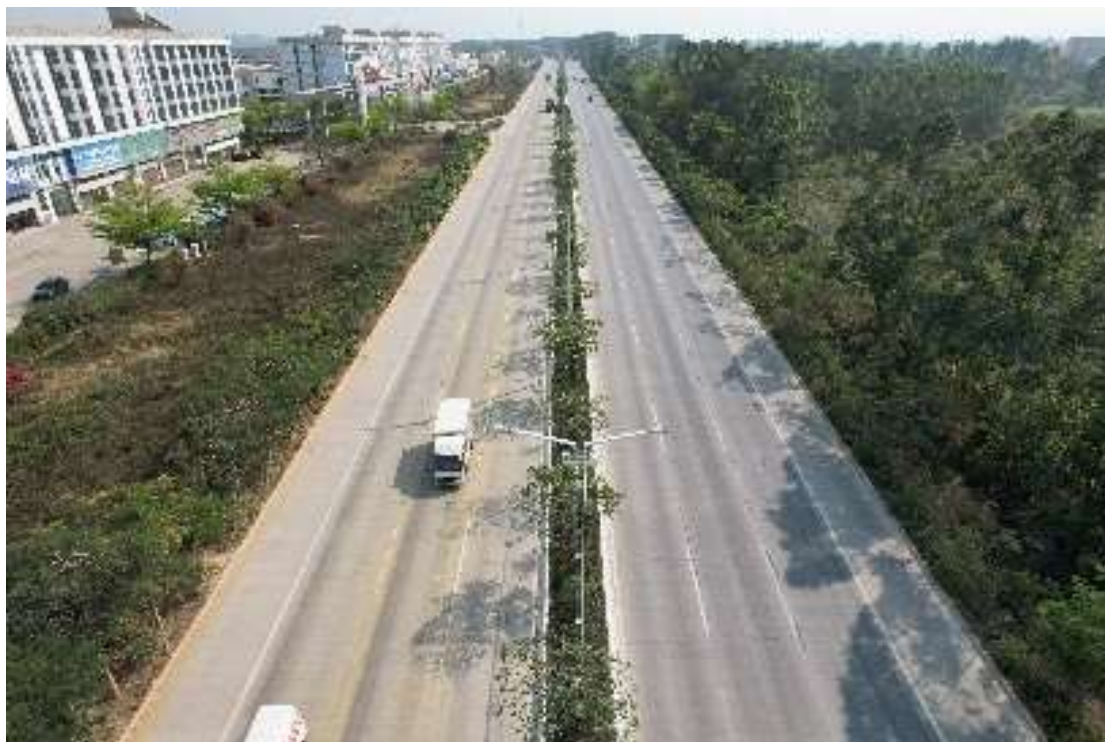
边坡防护工程 2
