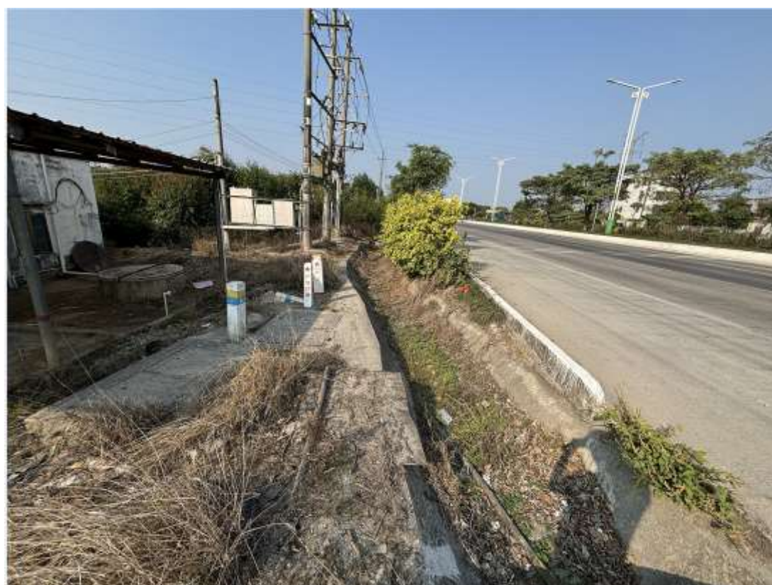
建成后路边排水沟
