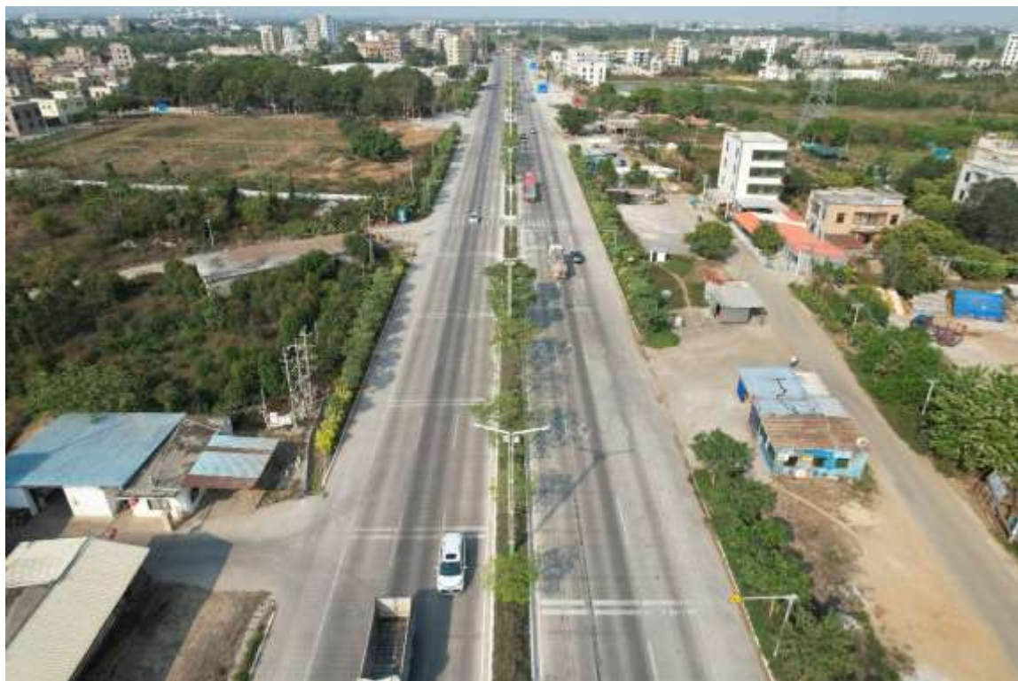
建成后航拍图（道路起点）
