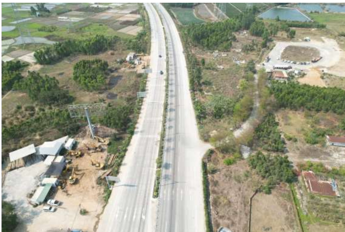
建成后航拍图（道路终点）
