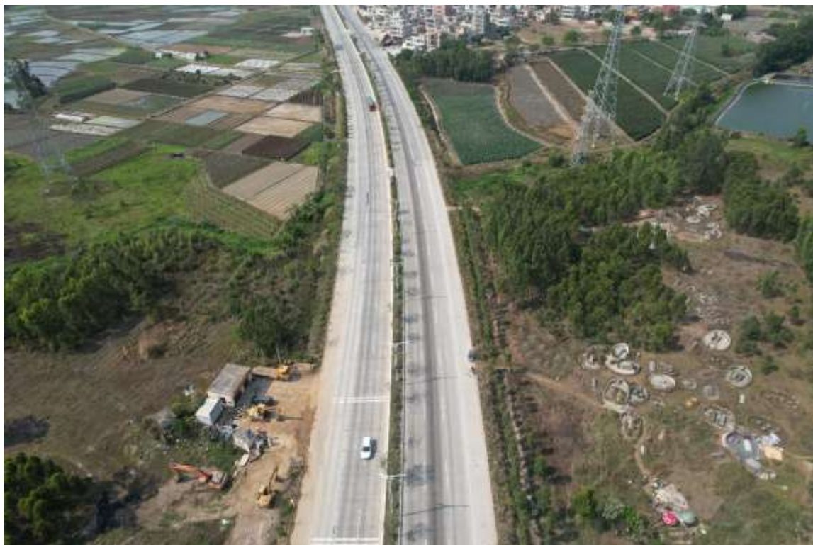
建成后航拍图（道路中段）
