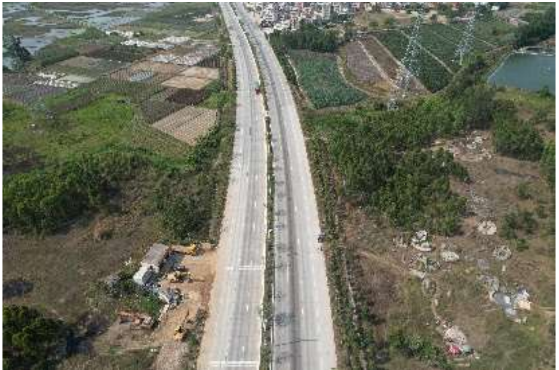
边坡防护工程 1
