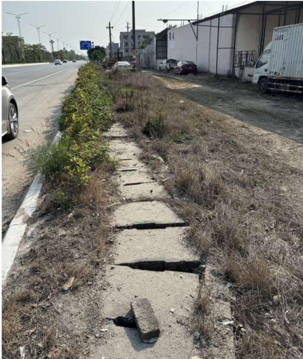
建成后截水沟照片
