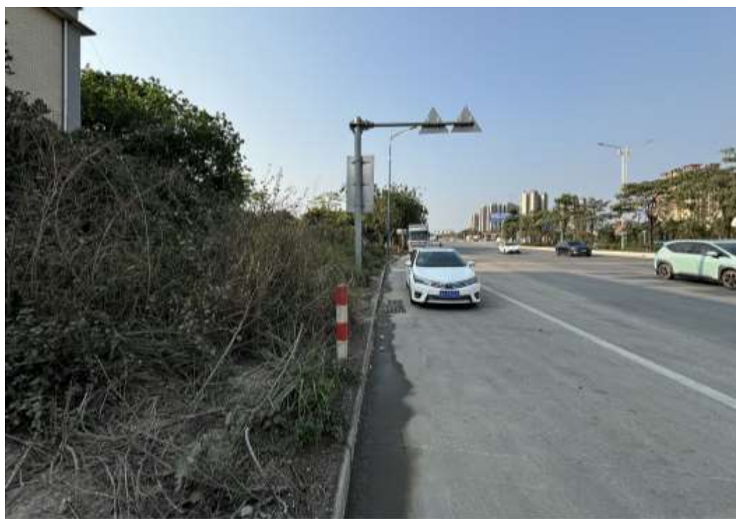
建成后影像图（道路起点）
