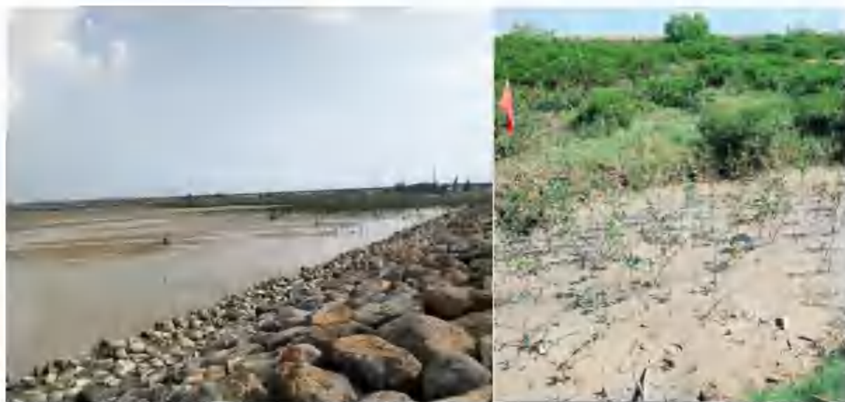
图 3.1.1-5 靠海侧幼苗区现场照片
