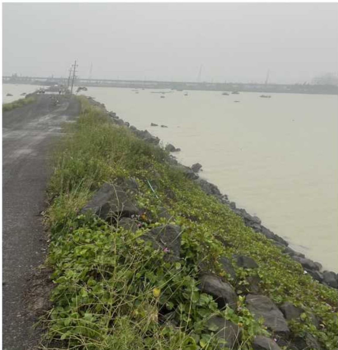
图 2.6.3-5 岸线现状照片
