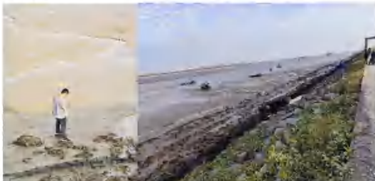
图 7.5.2-1 RTK 测量靠海一侧坡脚线照片
