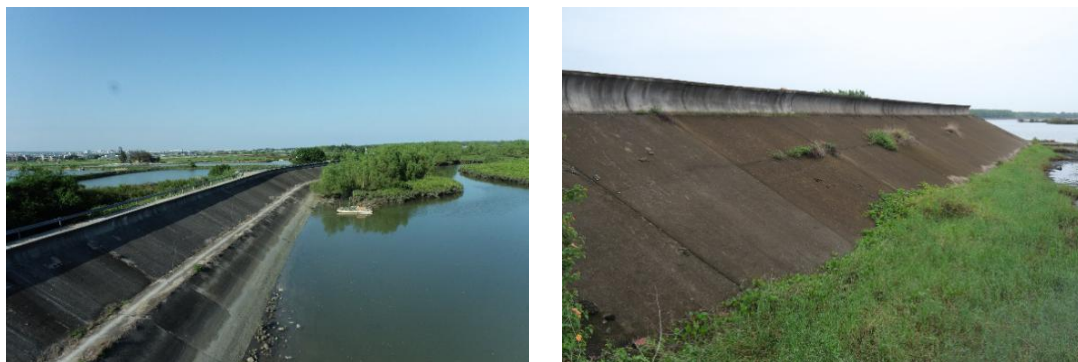
图 3.2.2-26 拟改造海堤现状照片
