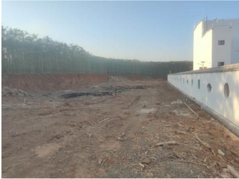
图 3-2 项目升压站现状
