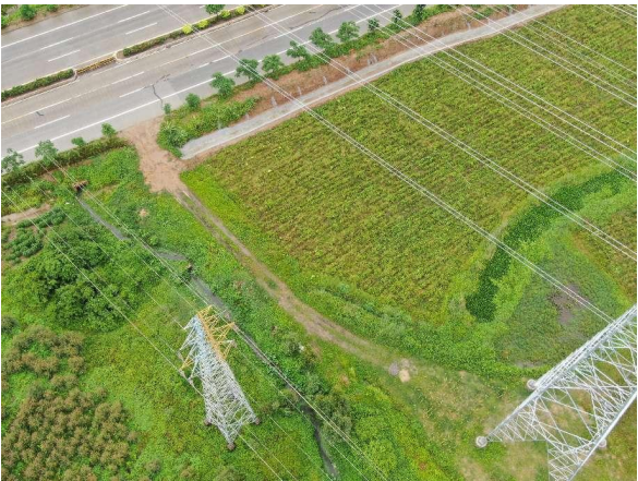
图 1-5 施工道路区监测点 (监测植被恢复情况)
