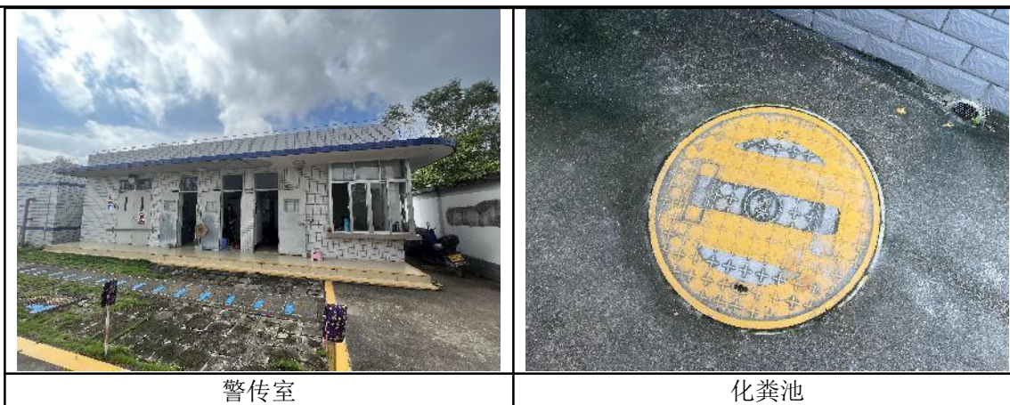
图 3-4 110kV 长山站现状照片
